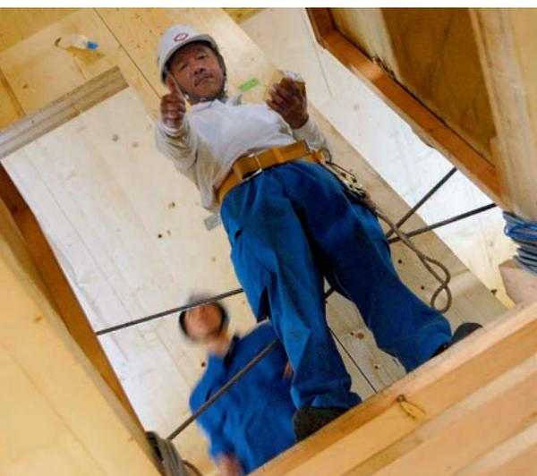
stati utilizzati oltre 250 m<sup>3</sup>: pannelli di legno massiccio di spessore tra i 5 e i 30 cm incollati a strati incrociati, secondo il sistema costruttivo X-LAM, tecnica sperimentata una decina d'anni fa in Germania ma sviluppata e perfezionata in Italia), proviene da foreste certificate per la gestione sostenibile e possiede qualità estetiche per un utilizzo architettonico funzionale e creativo.
